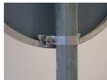
SLIKA 1, Pritrditev objemke na bandažni-ojačitveni profil prometnega znaka in na drog.
